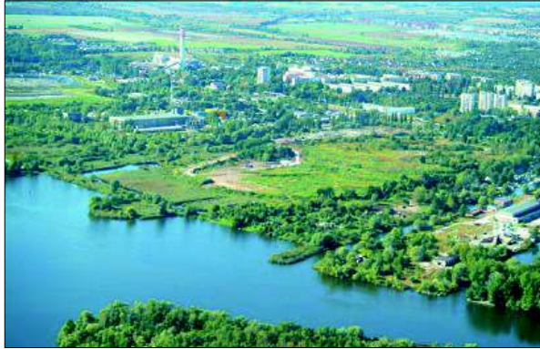
2004 rok – teren przeznaczony pod budowę oczyszczalni „Pomorzany”.
