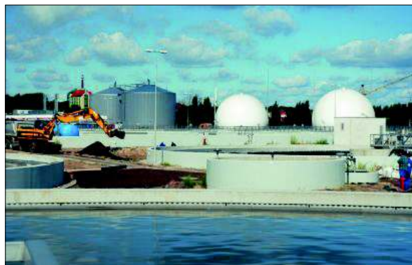
Oczyszczalnia Ścieków „Pomorzany” – wrzesień br.
