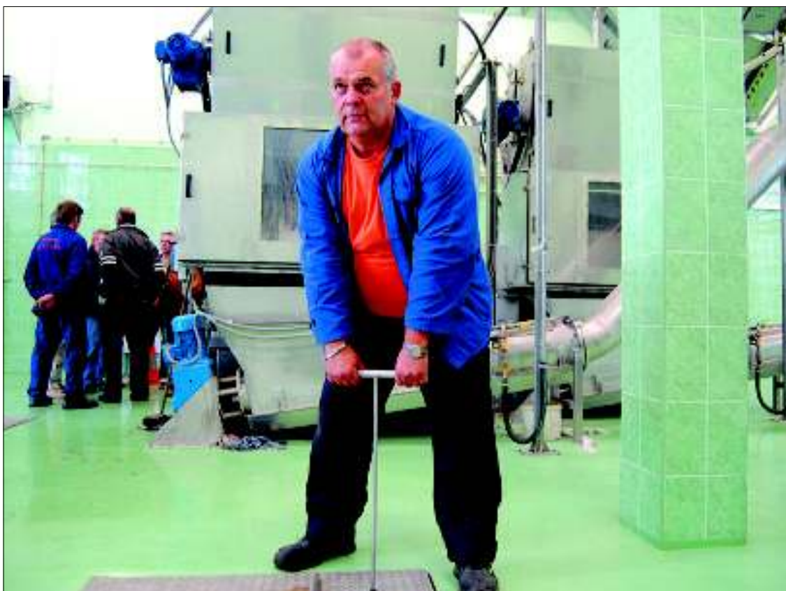
Brygadzysta Tomasz Baszuro sprawdza działanie urządzeń przepompowni Grabów.
